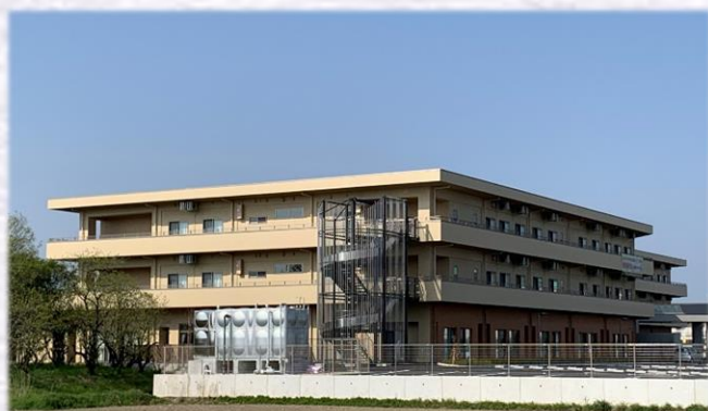
北東より全景
