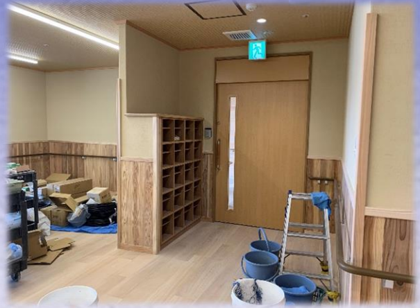
1F 多床室玄関
