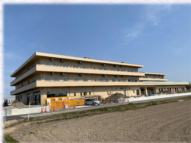
南西より全景
