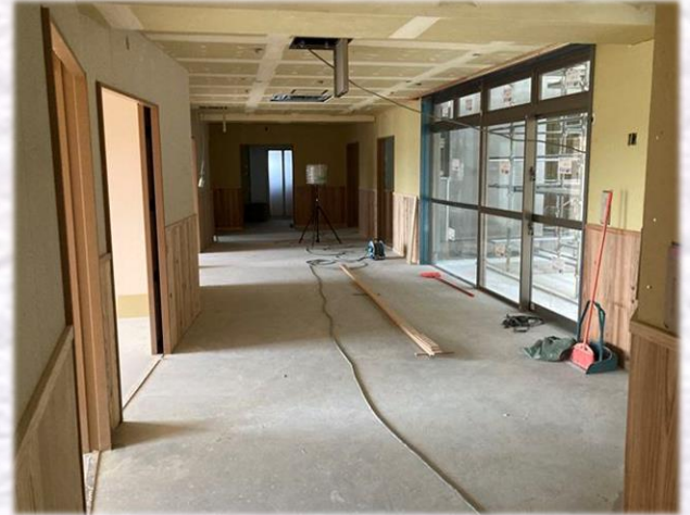
2F ユニット談話室クロスパテ処理状況
