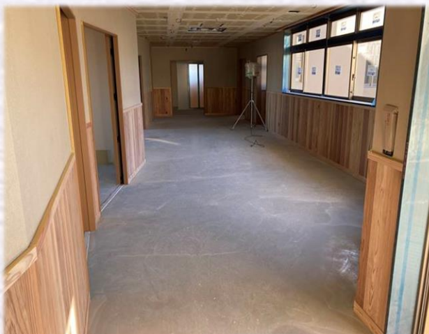
3F ユニット談話コーナー 腰杉板貼り状況
