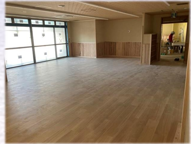
1F ユニット食堂床貼り完了
