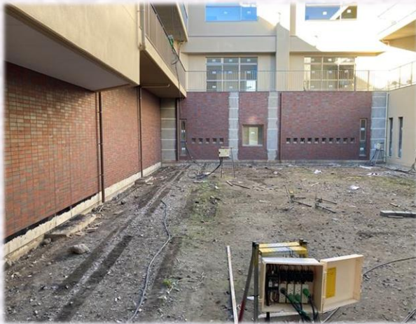
西側中庭外部足場解体撤去状況
