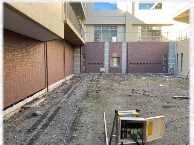
西側中庭外部足場解体撤去状況
