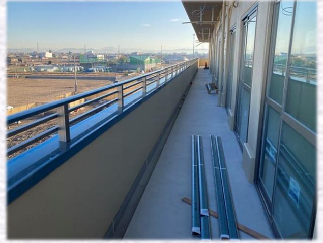
3F バルコニー手摺取付
