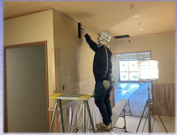
1F ユニット廊下 壁珪藻土刷毛引き仕上
