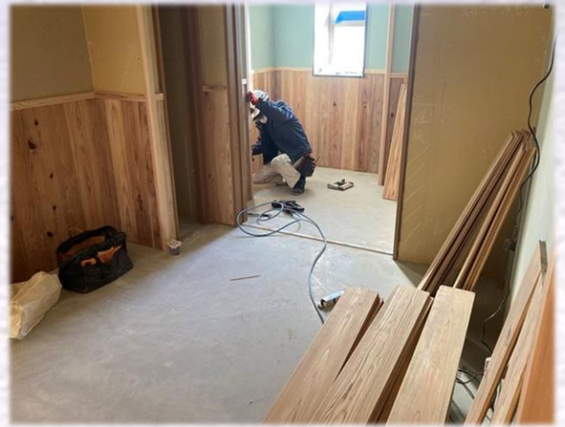
2F ユニットWC腰杉板貼り
