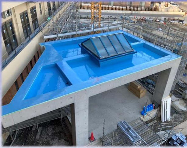
車寄せ屋根 ウレタン防水施工
