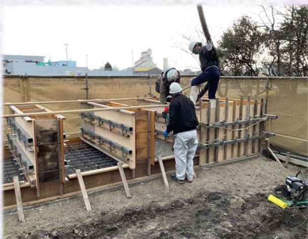
外構 受水槽基礎コンクリート打設
