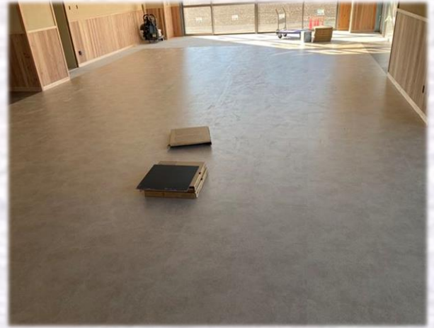
1F 多目的室床施工状況
