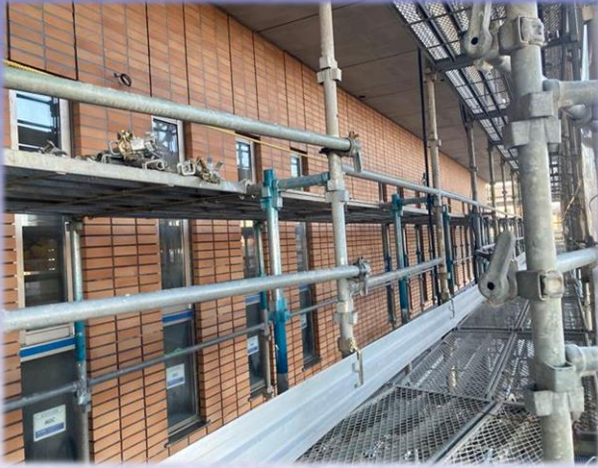
1F 北面外壁 タイル貼り状況
