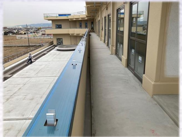
3F バルコニー手摺取付状況
