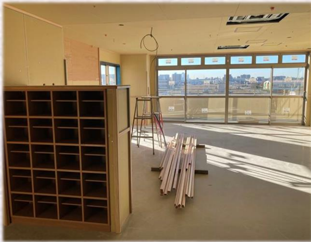
3F ユニット下足入れ設置状況
