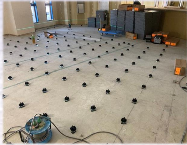
1F 事務室 OAフロアー施工状況
