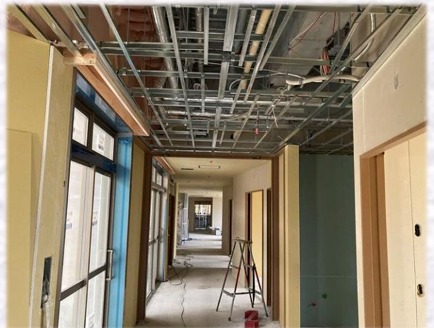
3F ユニット廊下軽量下地組
