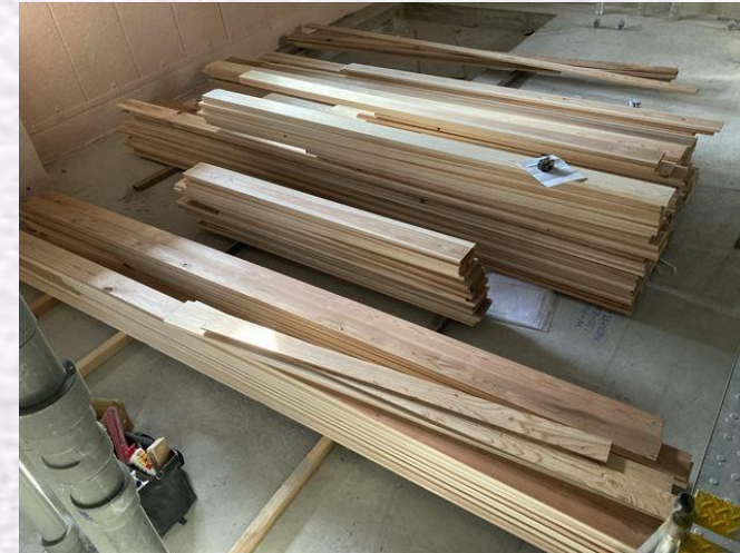
カーテンボックス木材料 1 階分納品（愛知県認証材）
