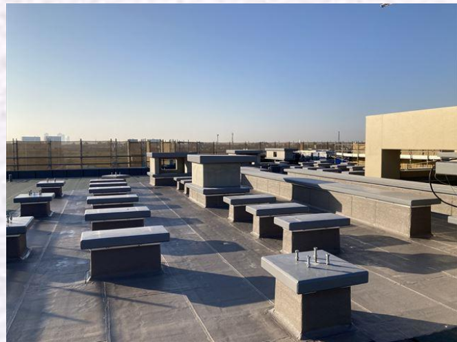
屋上設備架台周りアスファルト防水、ウレタン防水状況
