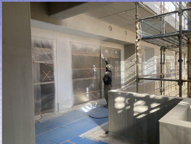
3F 南面外壁 吹付タイル ベース吹付状況
