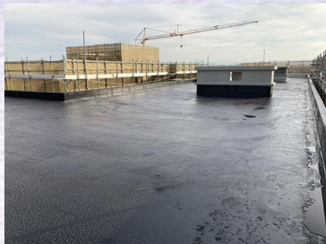
屋上 アスファルトの防水 ライマー塗布状況
