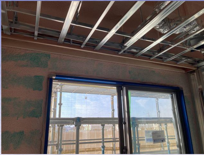
1F 多床室カーテンボックス取付状況
