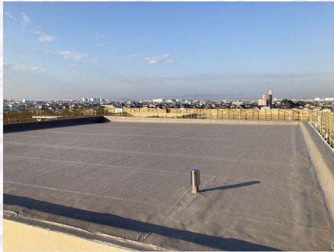
階段室屋根断熱アスファルト防水完了
