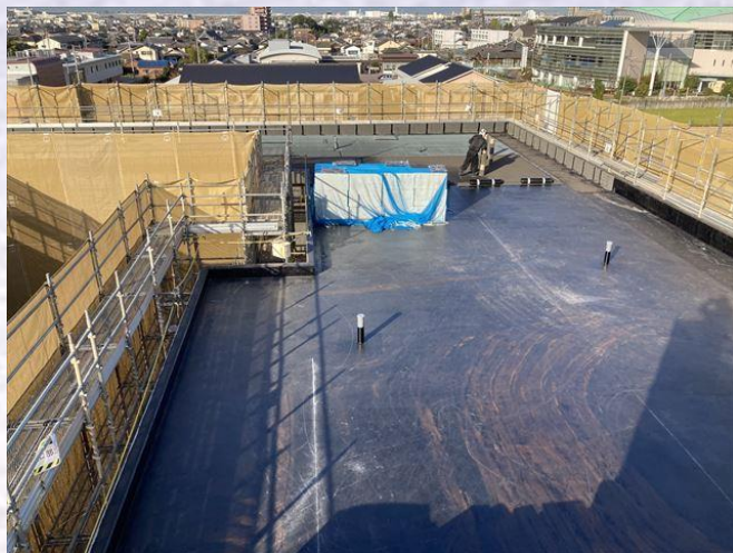
屋上アスファルト防水状況（テラスガーデン）
