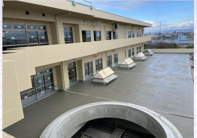
2F テラスガーデンシンダーコンクリート打設完了
