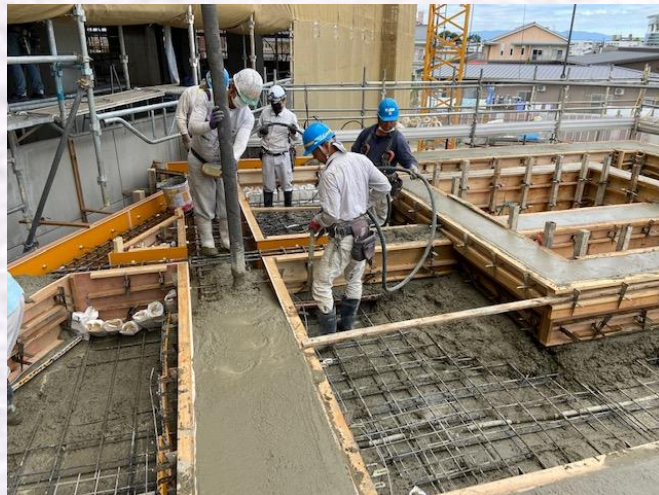
エントランス立上りコンクリート打設状況
