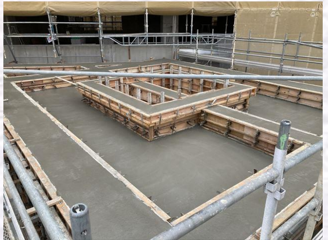
エントランス立上りコンクリート金罫押え
