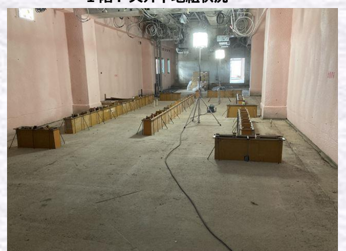
1F 厨房排水ピット枠取付
