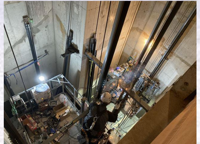
エレベーター据付工事
