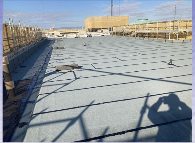
屋上 アスファルト防水施工状況
