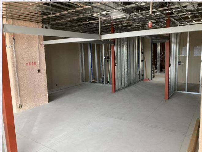
1F 多床室 壁・天井下地組状況
