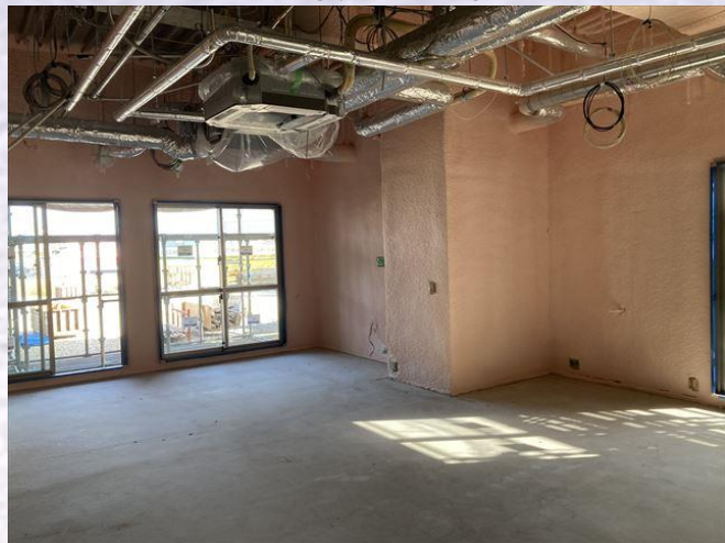
1F 外壁発泡ウレタン吹付完了状況、設備天井内配管状況近
