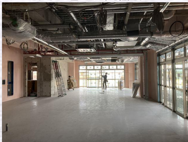
1F 多目的室天井杯設備配管 レール取付状況
