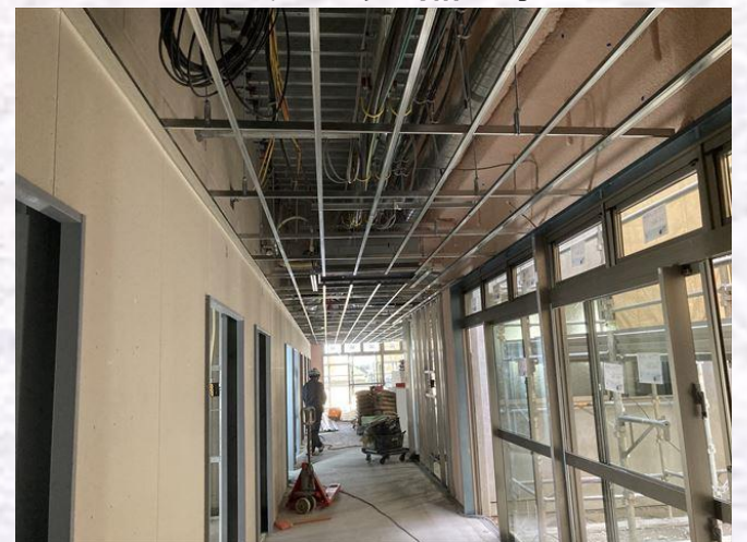
1階 F 天井下地組状況
