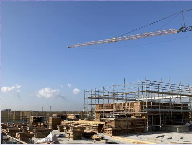
屋上階段室、機械基礎型枠組立状況
