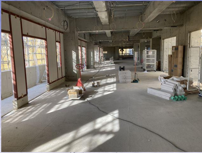
3F 外壁 A L C 建込み
