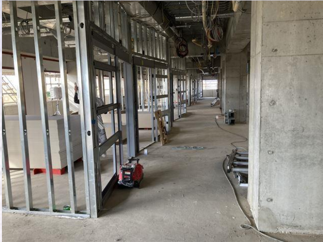
2F 耐火間仕切下地完了軽量サッシ枠取付状況
