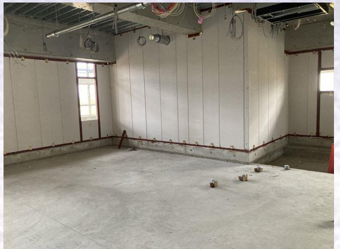
2F 外壁 ALC 建込み状況
