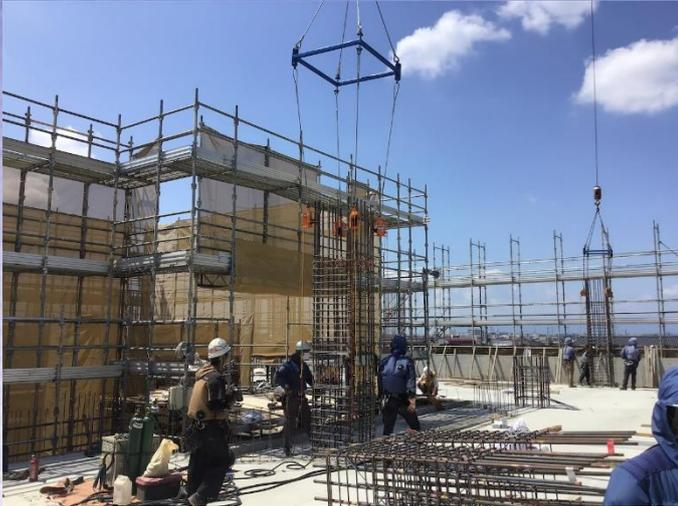
3階A工区柱配筋状況
