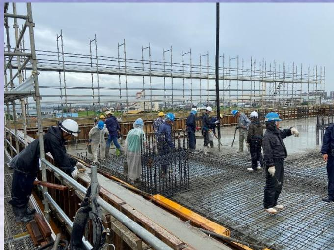
2階立上り躯体B工区コンクリート打設状況
