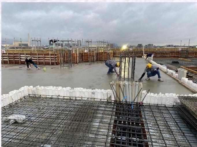
2階立上り躯体B工区コンクリートスラブ金鍍押え状況
