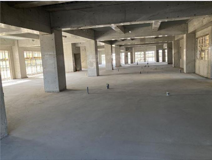
1階B工区 型枠解体完了状況
