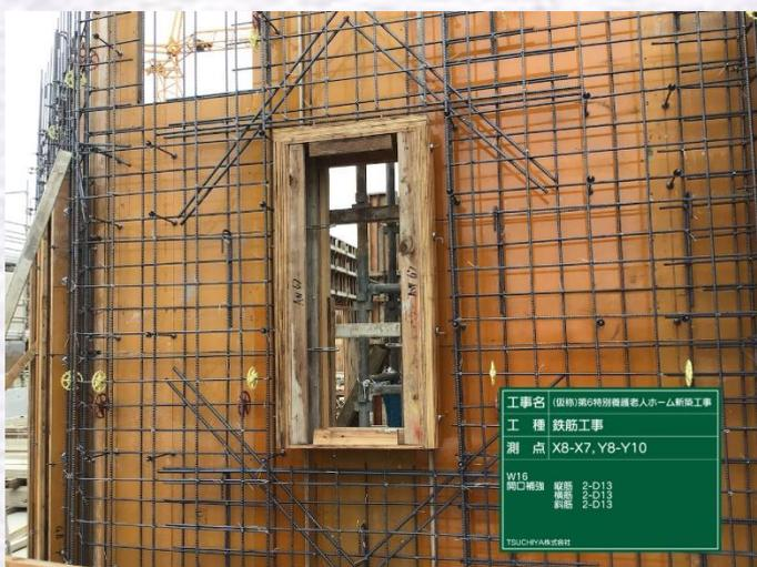
3階立上り躯体B工区壁配筋状況
