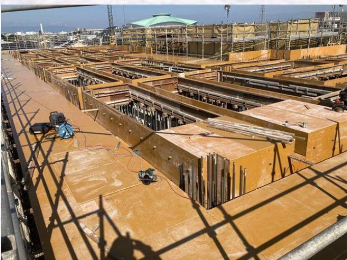
3階立上り躯体B工区梁架け、底スラブ貼り状況
