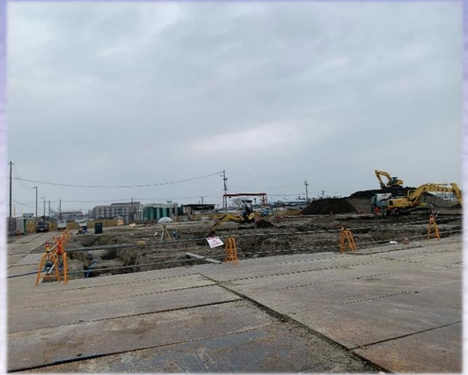
西側擁壁・仮囲
