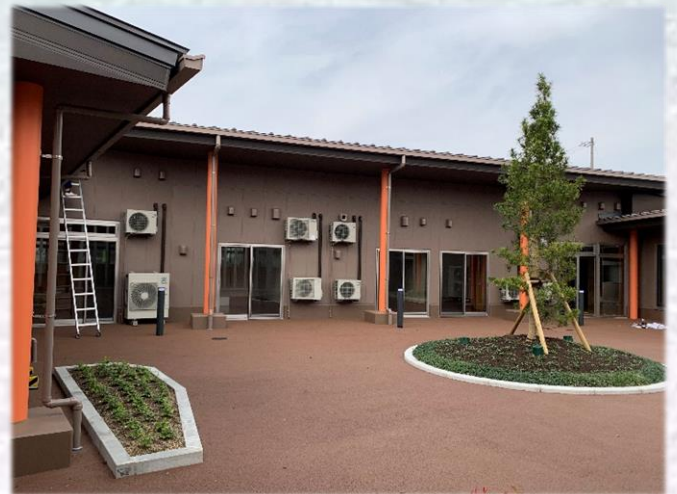
中庭から見た短期入所居宅・体験居室
