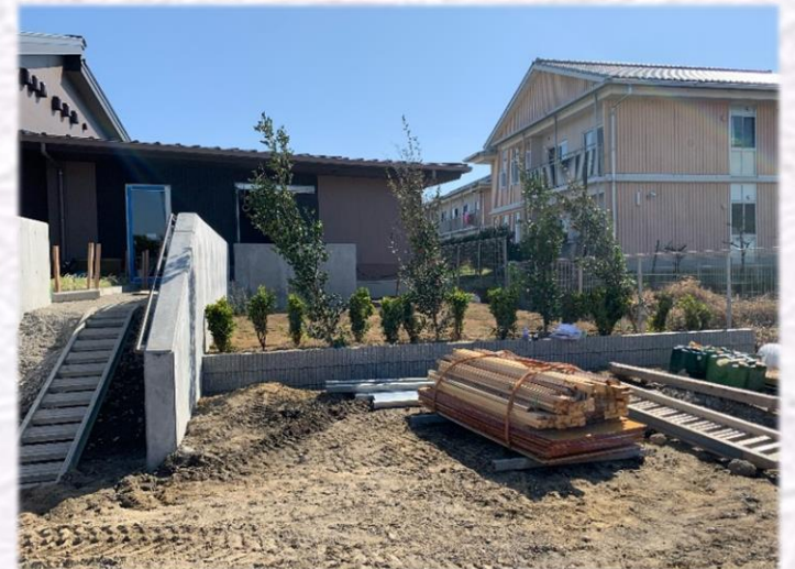
女性居室エリア玄関及び階段・植栽
