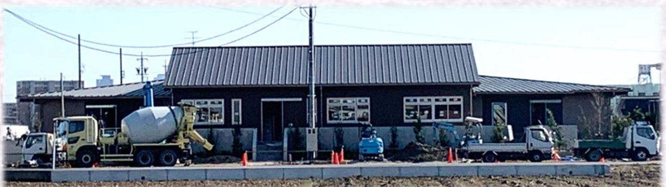
令和3年3月中旬の現場状況（工事風景） 3月15日撮影
