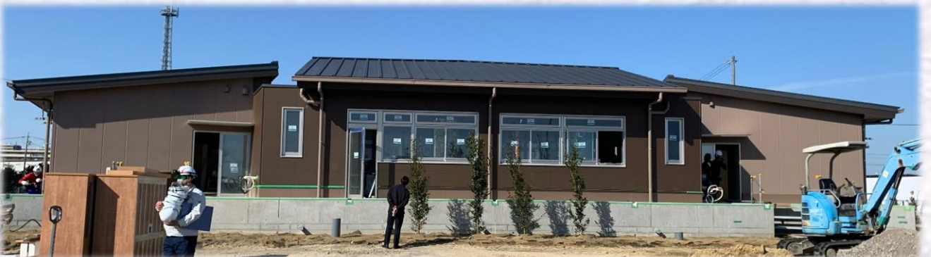
上写真：正面（北側）・下写真：裏側（南側）
