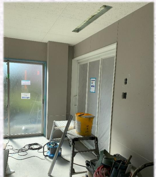
上写真：風呂・下写真：脱衣室
