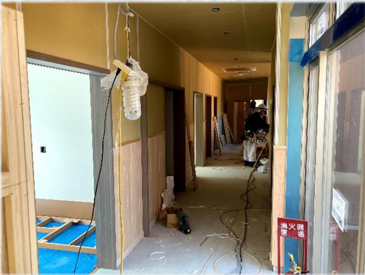
居室エリア廊下
