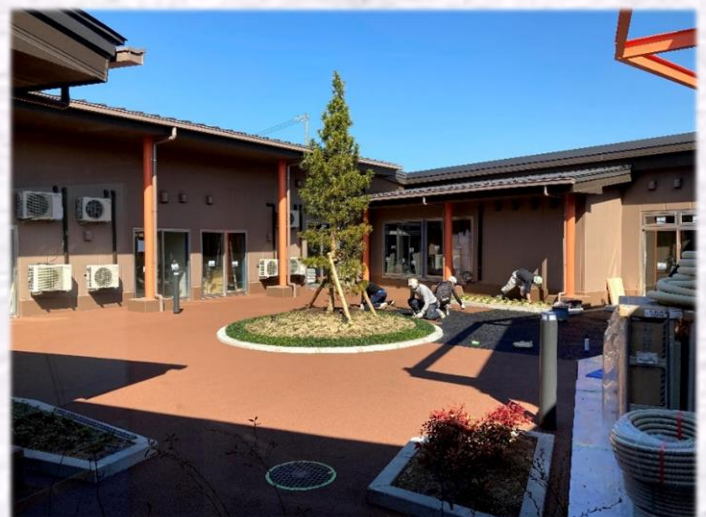
デイルーム側から見た中庭風景
