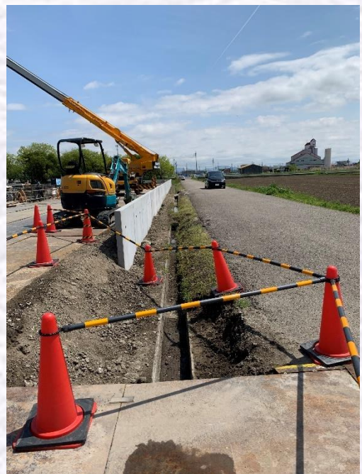
南側擁壁工事
